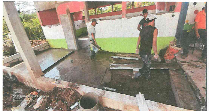
Foto 2: realizando el cambio de piso de concreto.
