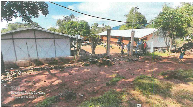
Foto 3: sustitución de malla perimetral.
